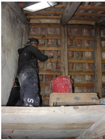
Här understryks skarvarna med nöthårsfärskt bruk.
