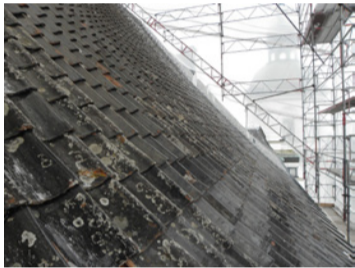
Teglet har återlagts på plats.
