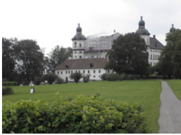
Renoveringsarbetet är uppelat i etapper, och beräknas vara klart år 2020.
